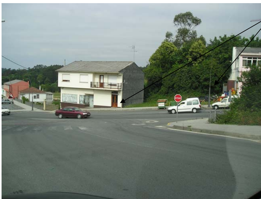
Vista del Solar objeto del presente proyecto, desde la confluencia de la Calle Víctor Velasco y la carretera Nacional 550.
